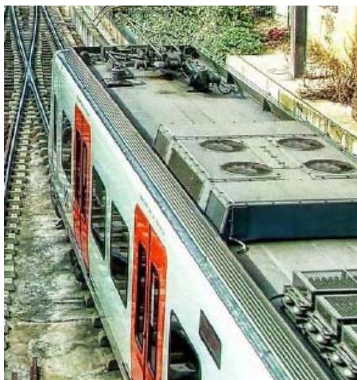
Equipo bomba de calor en techo de UT – 112
